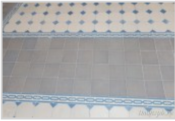
Восстановлено плиточное покрытие под иконостасом.
