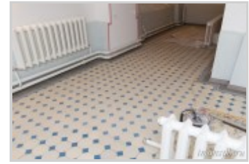
Участок пола, где в советский период было утрачено покрытие. Положена новая плитка по образцу исторической.
