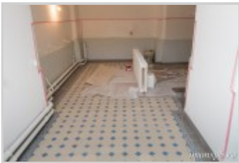
Часть подсобного помещения усыпальницы. В советский период плитка была утрачена полностью. В ходе реставрации восстановлена.
