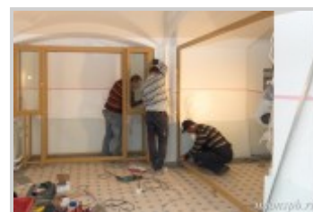
Установка металлических конструкций для музейных шкафов
