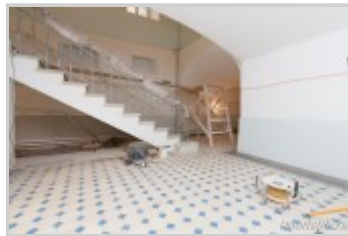
Часть храма-усыпальницы после ремонтных работ
