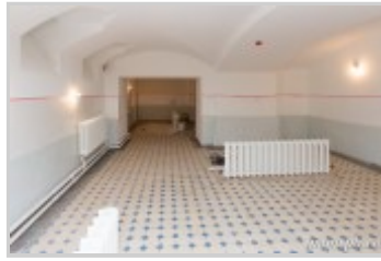
Часть храма-усыпальницы. Завершена покраска стен и сводов. Ведется покраска радиаторов отопления.
