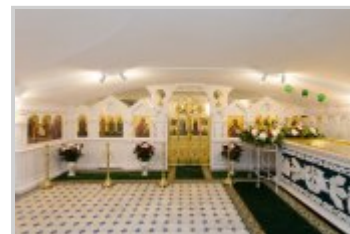
Завершился ремонт храма-усыпальницы
